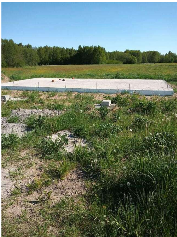
Zdjęcie 12. Fundamenty pod świetlicę. Źródło: Dokumentacja własna.
