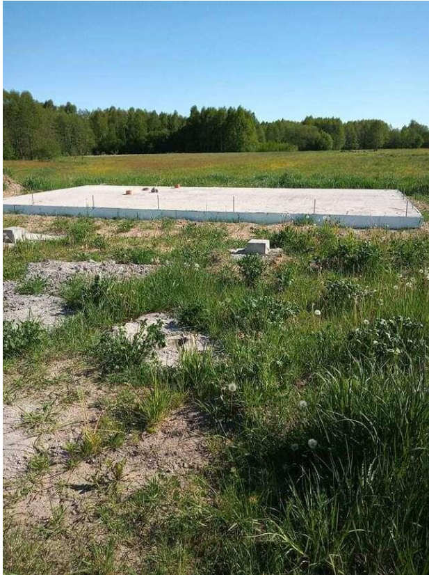
Zdjęcie 12. Fundamenty pod świątlicę. Źródło: Dokumentacja własna.
